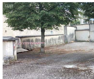
Deux emplacements de stationnements prévus pour recharger son véhicule électrique.
