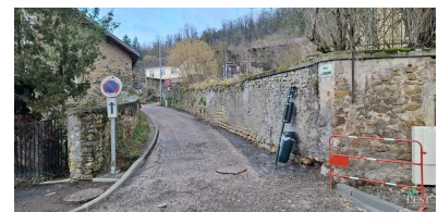
La dernière phase d'intervention de l'entreprise Eurovia Alsace Lorraine se fera par la pose de l'enrobé dans la ruelle du Vergeron.
