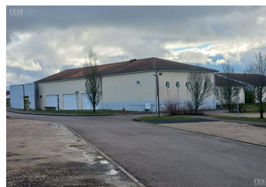
La salle socioculturelle de Frolois fait partie des bâtiments qui devraient être équipés de panneaux solaires.
