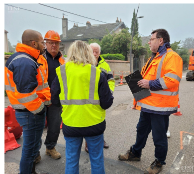
Le maître d'œuvre, Benoît Leblond, entouré des représentants de la mairie et du conducteur de travaux, fait un point sur les contraintes imposées par les gestionnaires de réseau.
